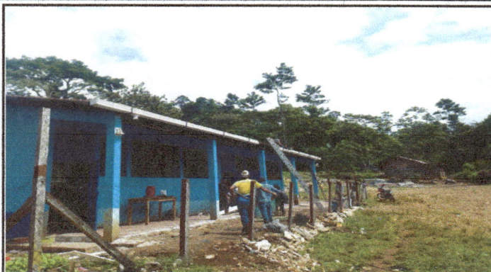
Foto1: se indentifica el avance de la rehabilitacion de canales
