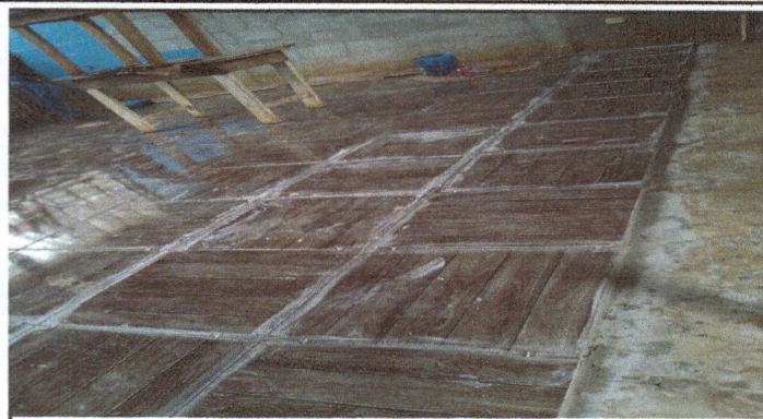
Foto 2: como se muestra en la fotografia el avance de la instalacion de piso ceramico aula I
