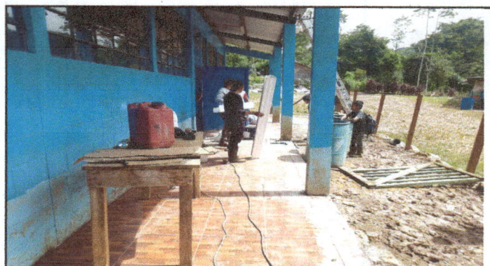
Foto 4: se indentifica el avance de la instalacion de piso ceramico en el corredor
